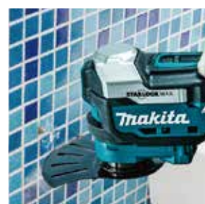
墙砖接缝开槽
