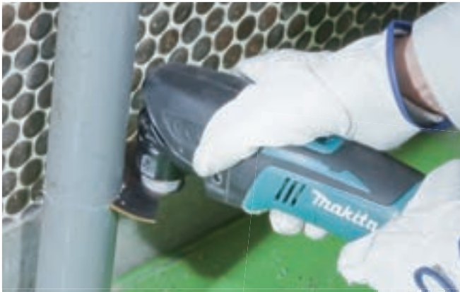
切割 PVC 管，玻璃钢管
