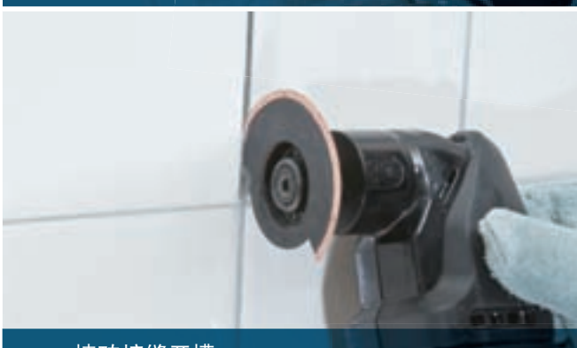
墙砖接缝开槽
